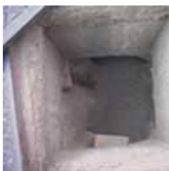
Cameretta di ispezione
